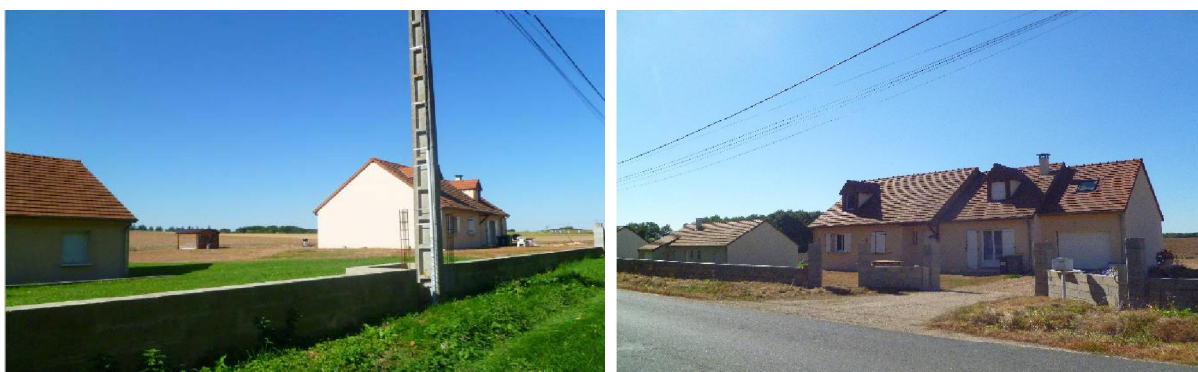
Entre Neuillé-le-Lierre et Montreuil-en-Touraine : construction de nouvelles maisons individuelles, dans un espace peu urbanisé, avec pour seule accroche deux anciens pavillons
